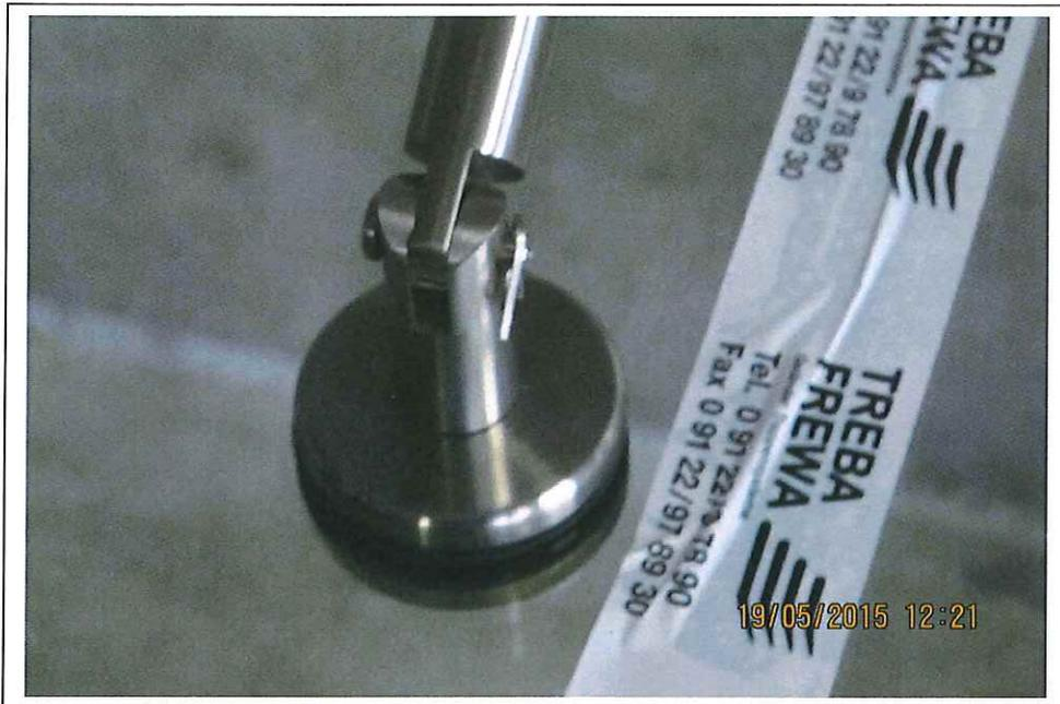
Bild 3 Ansatzpunkt des Abhängers an der Scheibe
